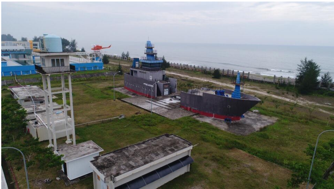
Gambar 2.13 Fire Ground, Menara Air, Ruang Pompa dan Ruang Genset
