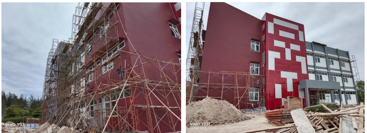
Gambar 2.8 Gedung asrama C
